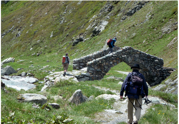
Brücke am Säumerweg im Bergell
